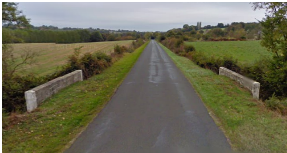
Exemple de pont avec parapet
